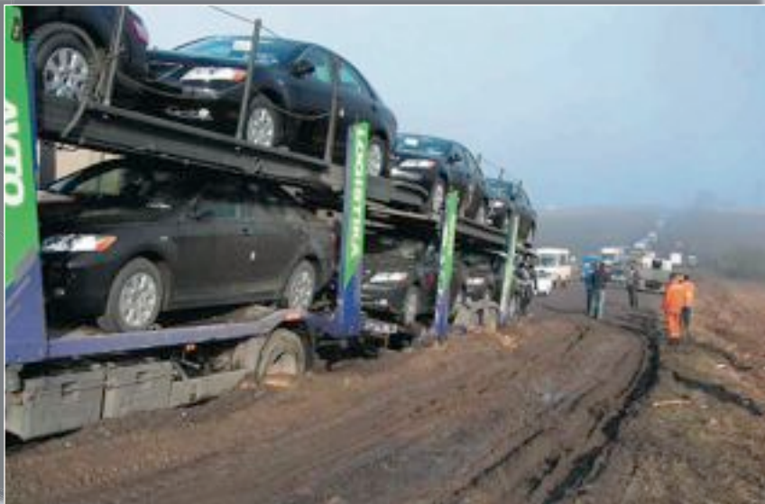
Рис. 6. Руйнування дороги через підтоплення в Рівненській обл.
