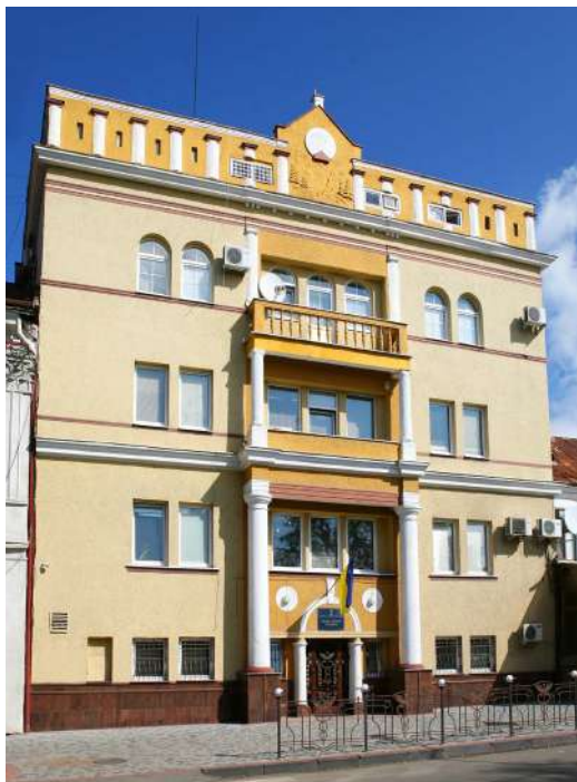
Адміністративна будівля Закарпатської митниці
