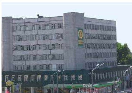
Адміністративна будівля Дніпропетровської митниці
