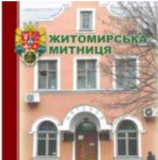
Адміністративна будівля Житомирської митниці
