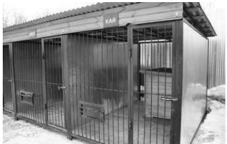
Бічні та задня стінка виготовлені з бляхи
