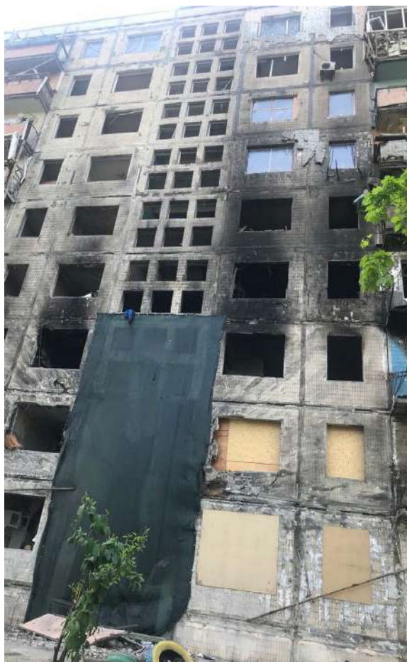
Іл. 14. Відновлювальні роботи в зруйнованому будинку на Оболоні. Травень 2022.
