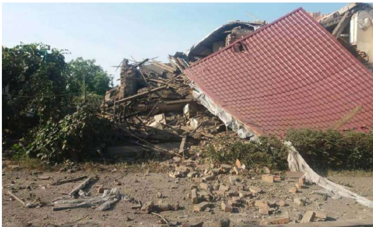
Іл. 4. Зруйнований ракетою будинок на Закарпатті. Травень 2022.
