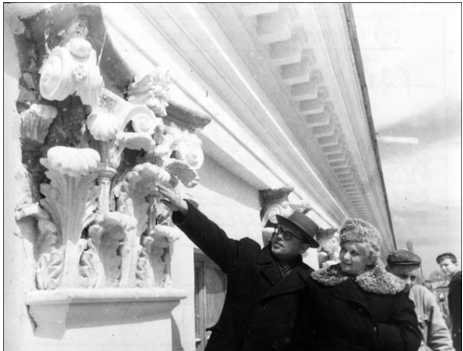
Архітектор Петропавловський В. П., засл. будівельник УРСР Алмазова С. Д. оглядають якість виконаних робіт з відновлення театру ім. А. Луначарського. 1957 р. Фото Акуленка І. Державний архів міста Севастополя, фонд фотодокументів, од. зб. 0-6311.
